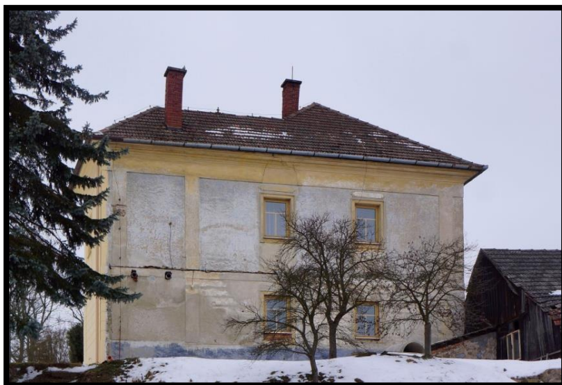
Stav východní fasády fary před zahájením opravy.
