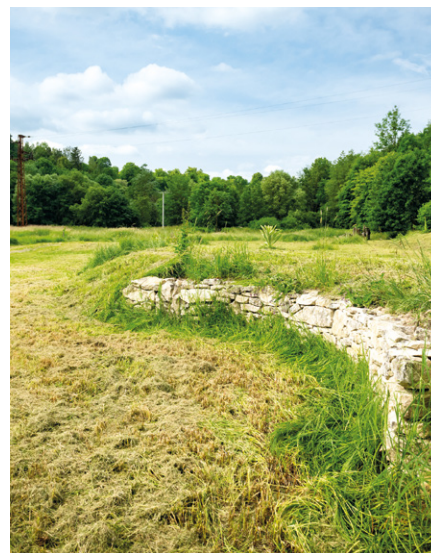
Přírodě blízká protipovodňová ochrana v Dolním Újezdě
