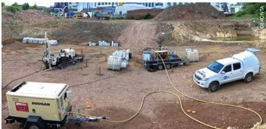
Sestava vysokotlaké injektáže (Frac-In) v sanačním výkopu pod bývalou odmašťovnou
