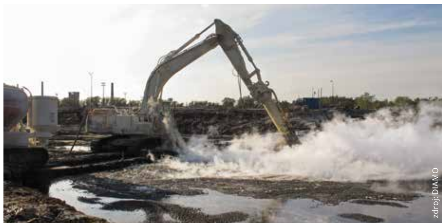
Aplikace vápna do surových ropných kalů v průběhu sanace
