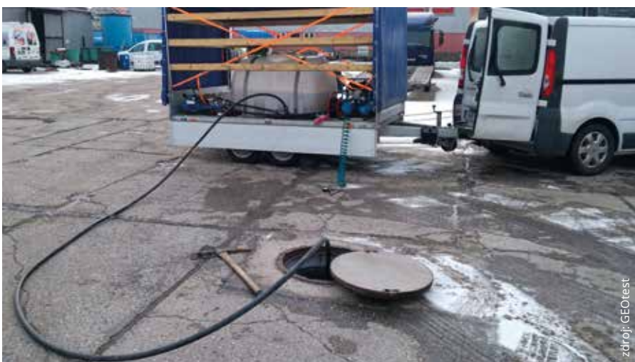
Obrázek 2: Tlaková injektáž PAL prostřednictvím mobilní aplikační jednotky
