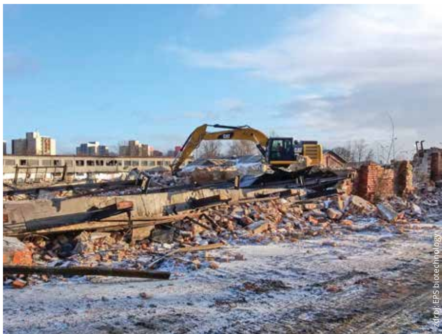
Sanace distribučního skladu PHM v Novém Bohumíně
