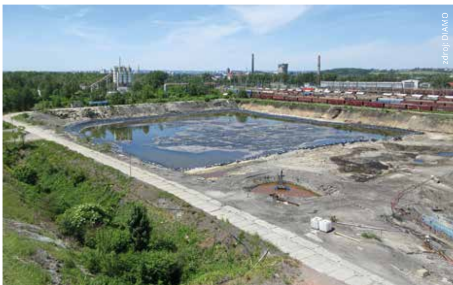
Aktuální pohled na lagunu R3 s krycí fólií proti průsakům atmosférických srážek do podlaží lagun
