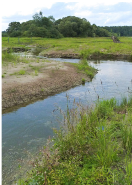
Obrázek 5: Obnova dřívě razantně regulovaného toku říčky Stropnice, první rok po obnově meandrů
