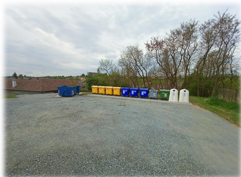
Nové kontejnerové stání na Bytovkách.
